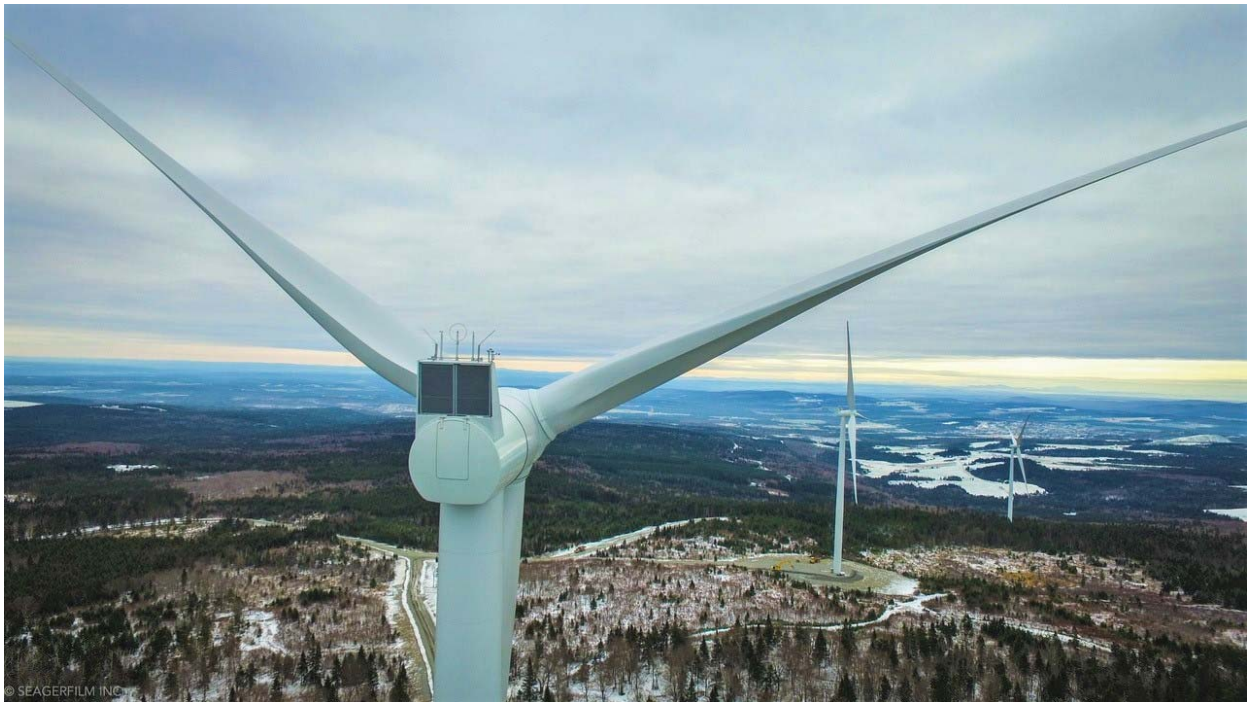
Vue du sommet d'une éolienne du Parc éolien Mont Sainte-Marguerite
